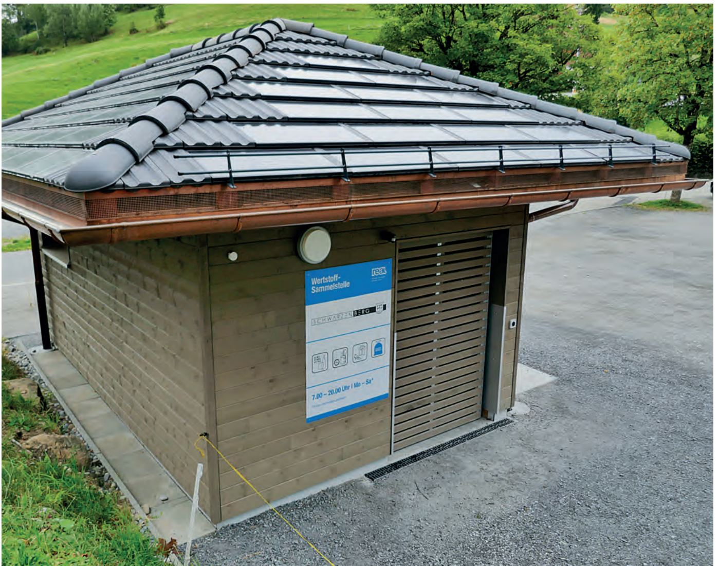
Die Solarmodule auf dem Dach sind erst auf den zweiten Blick als solche zu erkennen. Überschüssiger Strom wird in das Netz der ewl gespiesen.
