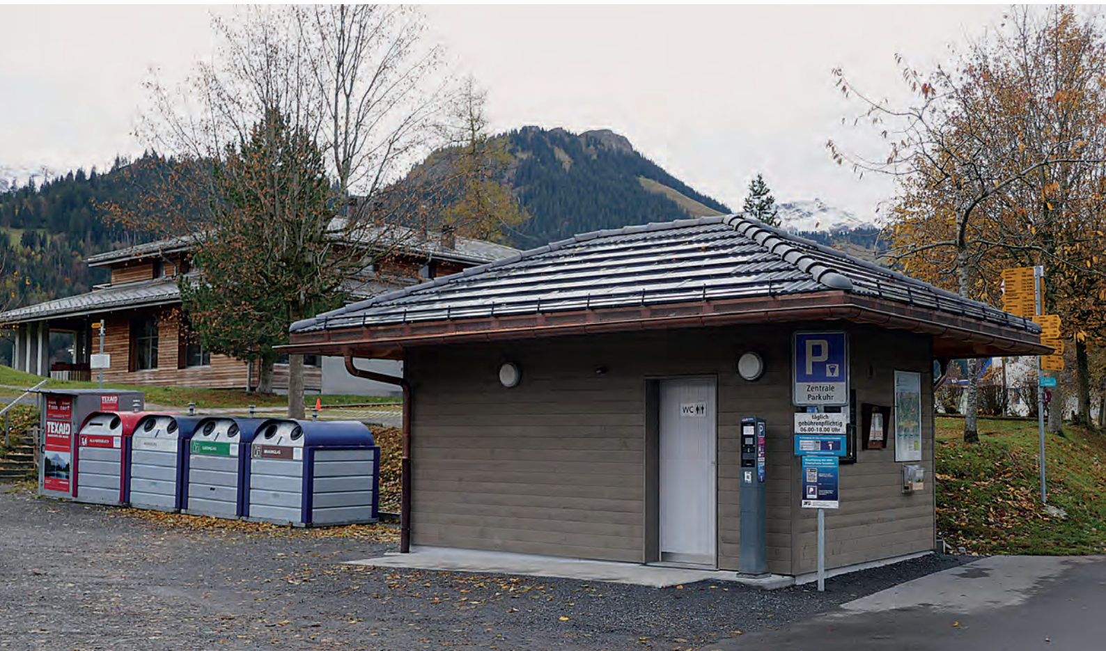
Der linke Gebäudeteil bietet Raum für die Kehrichtsammelstelle.
