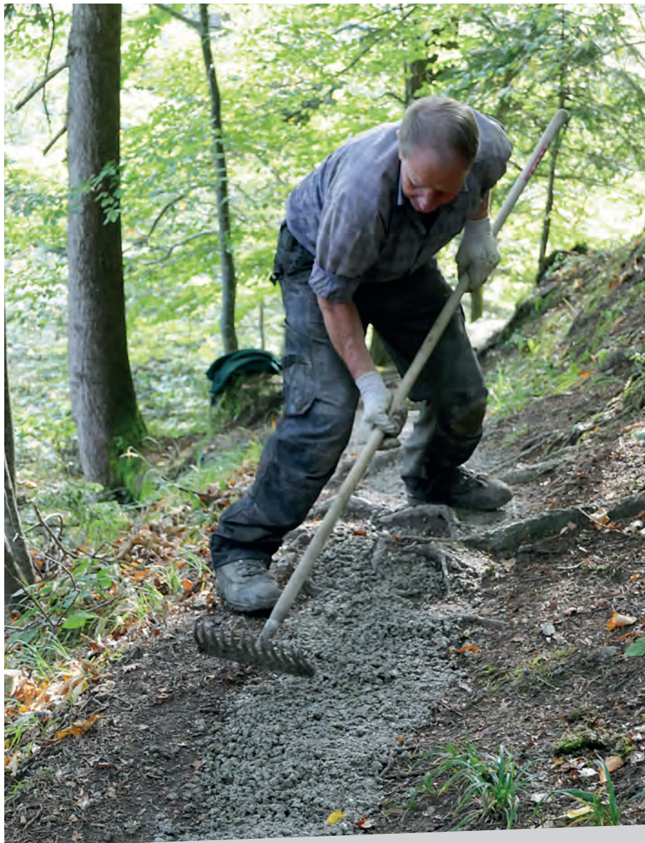
Fachmännische Verarbeitung der hinaufgetragenen Schottermischung durch den Eigenthaler Hansruedi Lipp
